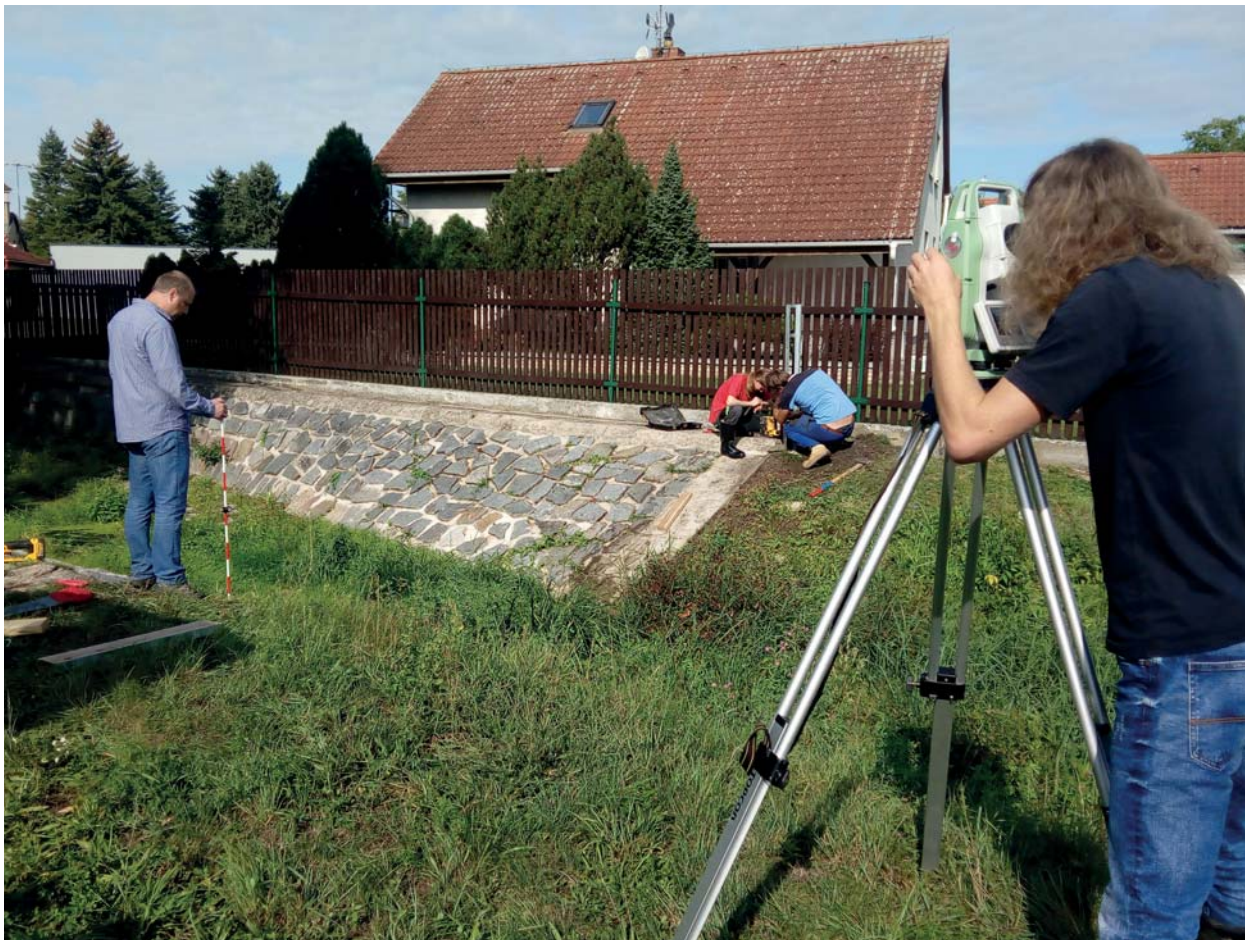
Instalace a geodetické zaměření profilu vodoměrné stanice Kosořice v projektu TAČR Beta2 TITSMZP809 „Vliv malých vodních nádrží na hladinu podzemních vod a celkovou hydrologickou bilanci s důrazem na suchá období“. Foto: R. Tyl
